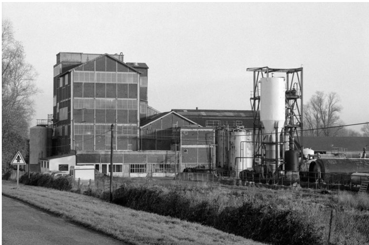
Vue d'ensemble, flanc sud.
