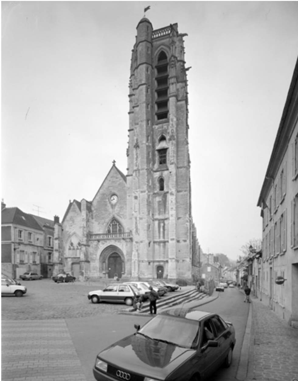
Vue générale de la façade occidentale et du parvis depuis la rue Saint-Crépin.
