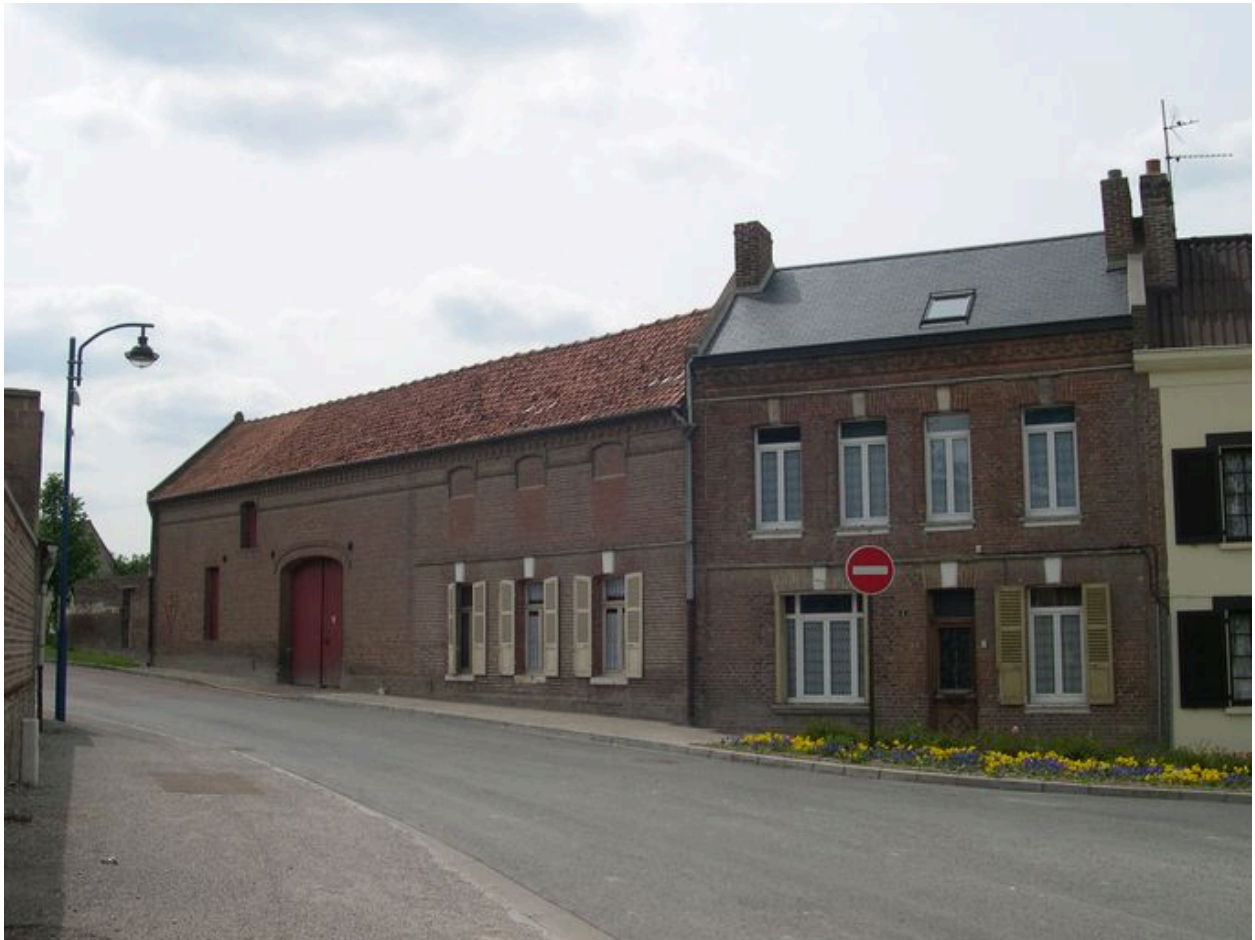
Maison et ferme, rue de Cagny.
