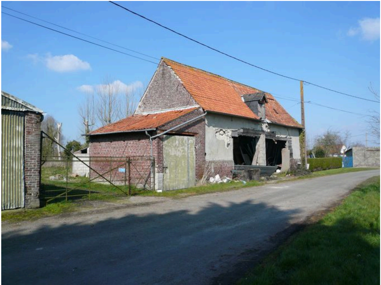
Vue de la seconde grange depuis la rue.
