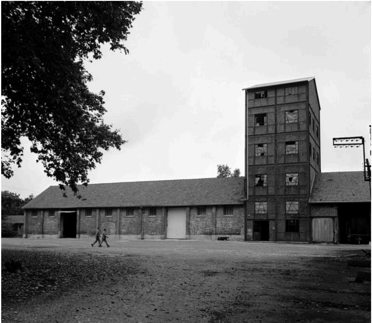
Vue d'ensemble sur cour (façade sud) de la distillerie de 1933.
