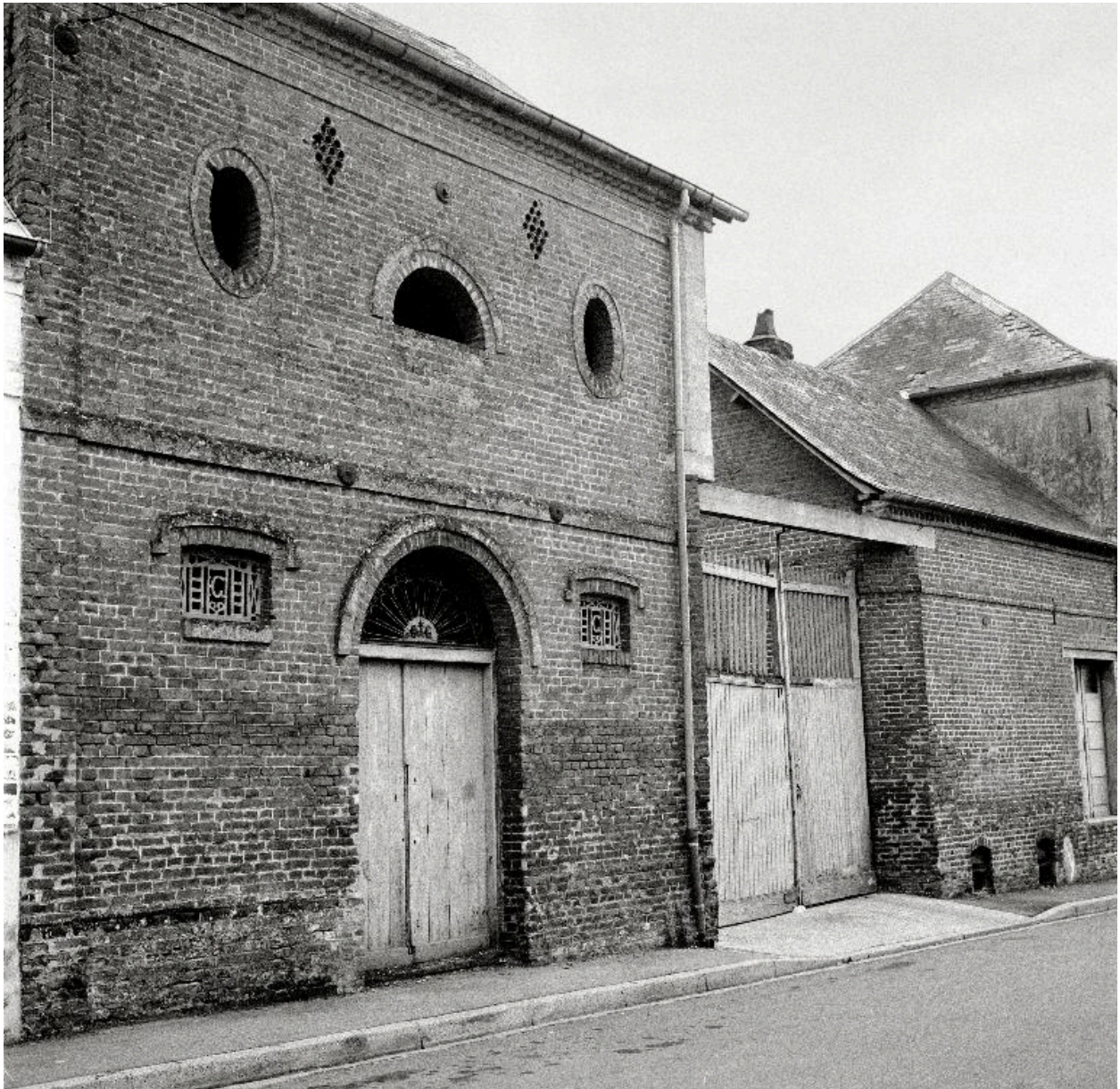
Vue partielle de l'entrepôt Grandsire (1880), en 1990.
