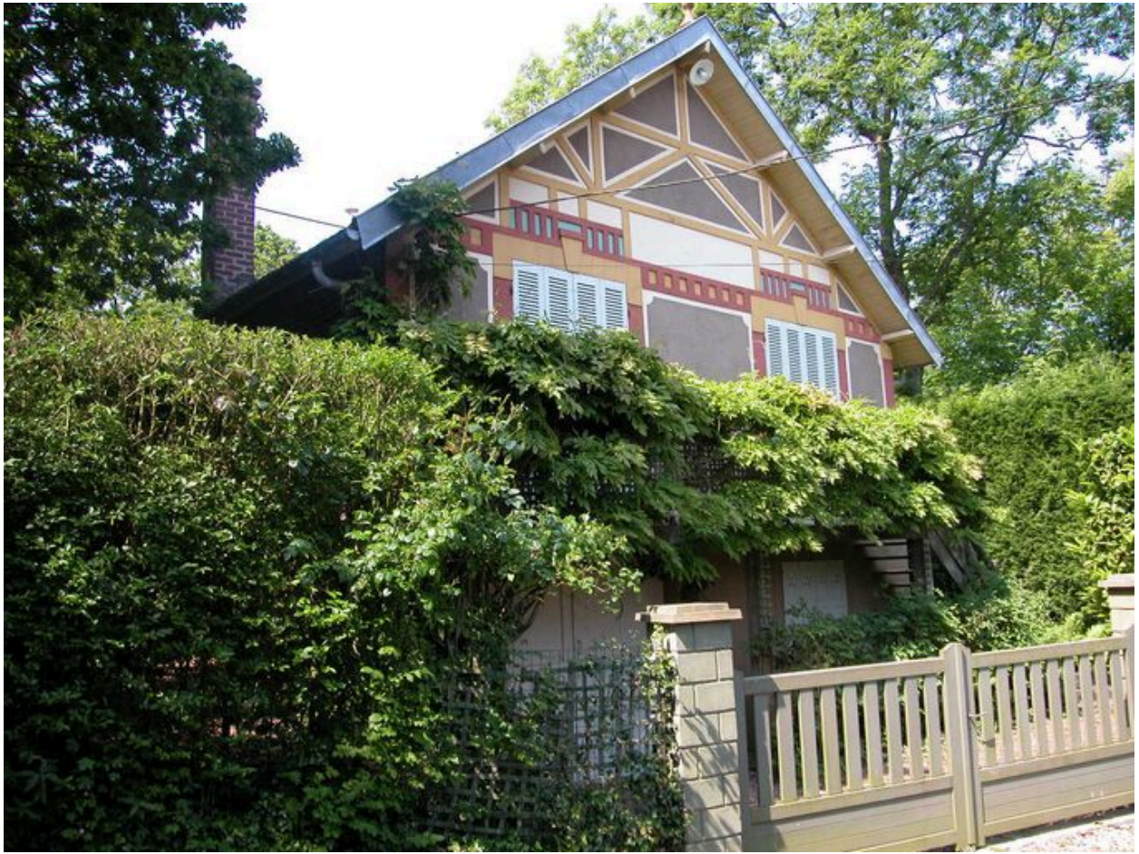
Vue d'ensemble depuis la rue.
