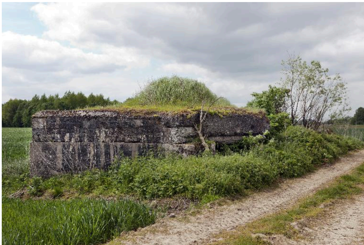
Vue latérale, vers sud-ouest
