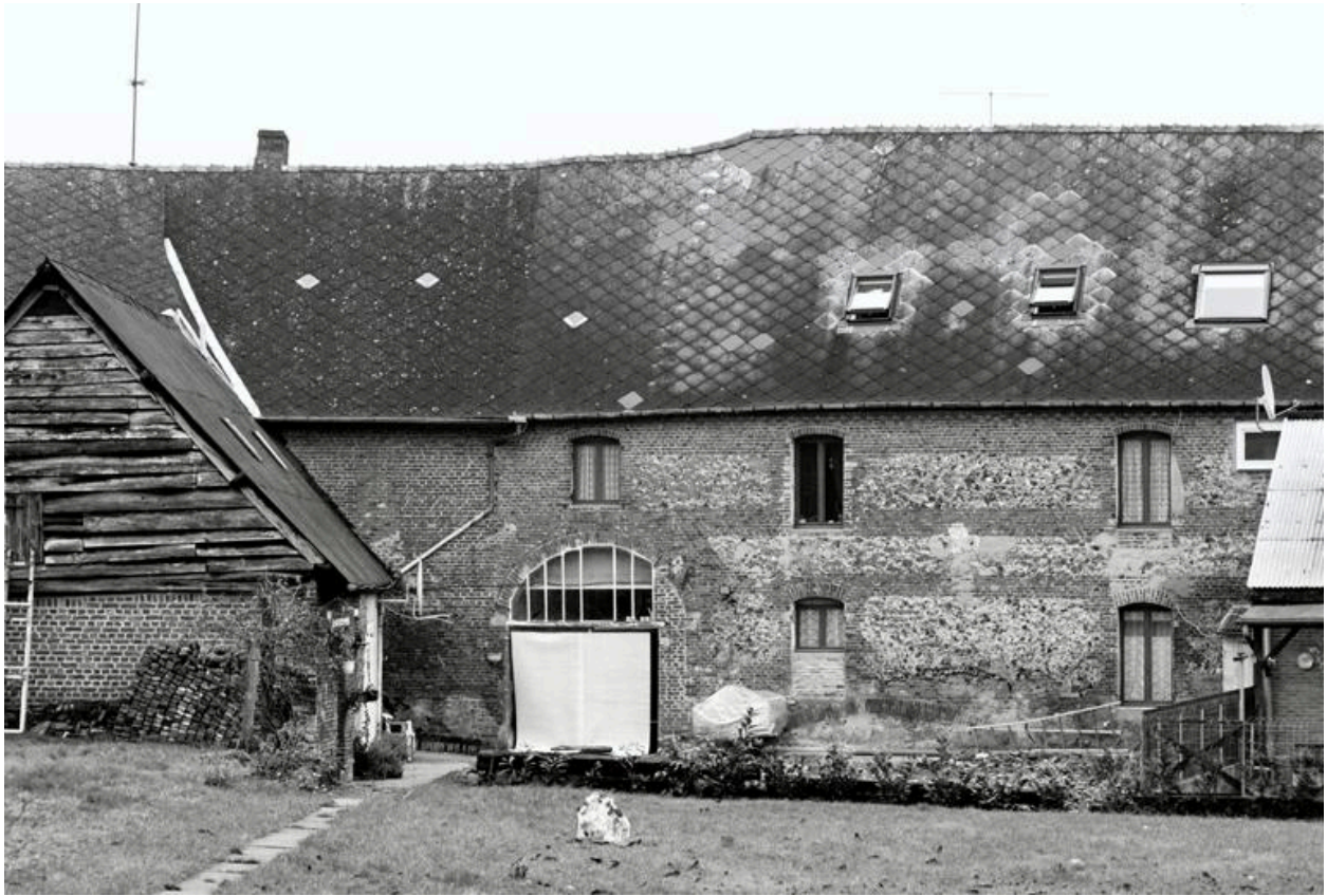
Vue de l'élévation postérieure sur la cour, construite en silex et brique.
