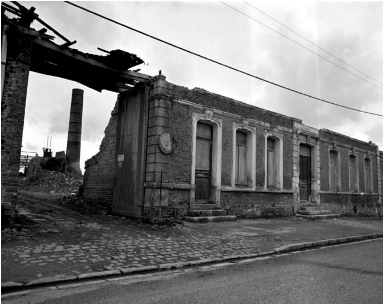
Bureau en cours de démolition (élévation antérieure).
