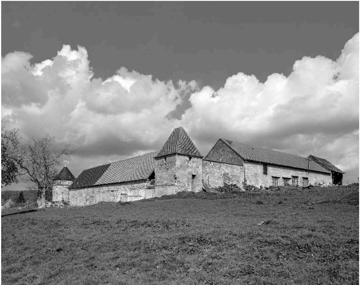
Vue de l'élévation externe des bâtiments sud-ouest et sud-est, depuis le sud.
