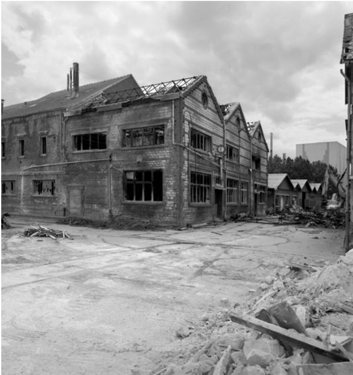
Démolition du laboratoire d'essais.
