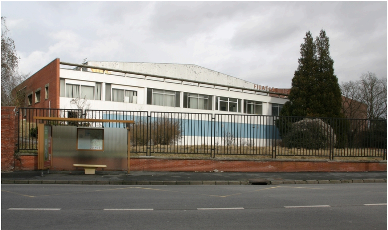
Façade antérieure de l'usine : au premier plan, les bureaux et la halle de 1957.
