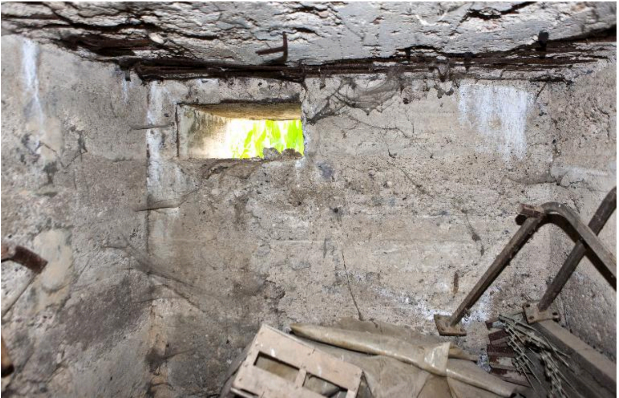
Vue intérieure, vers l'est
