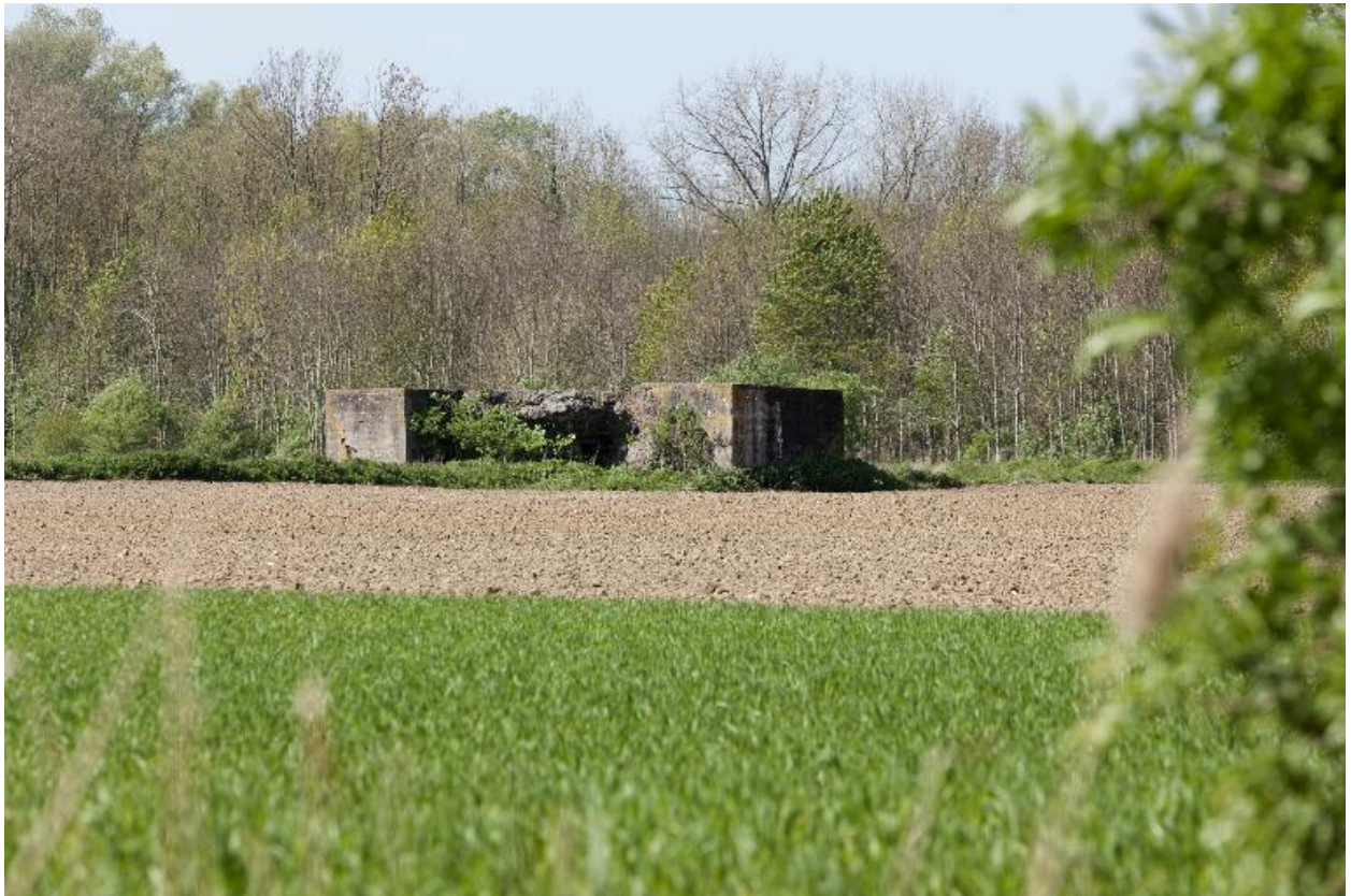
Vue générale vers le nord-est
