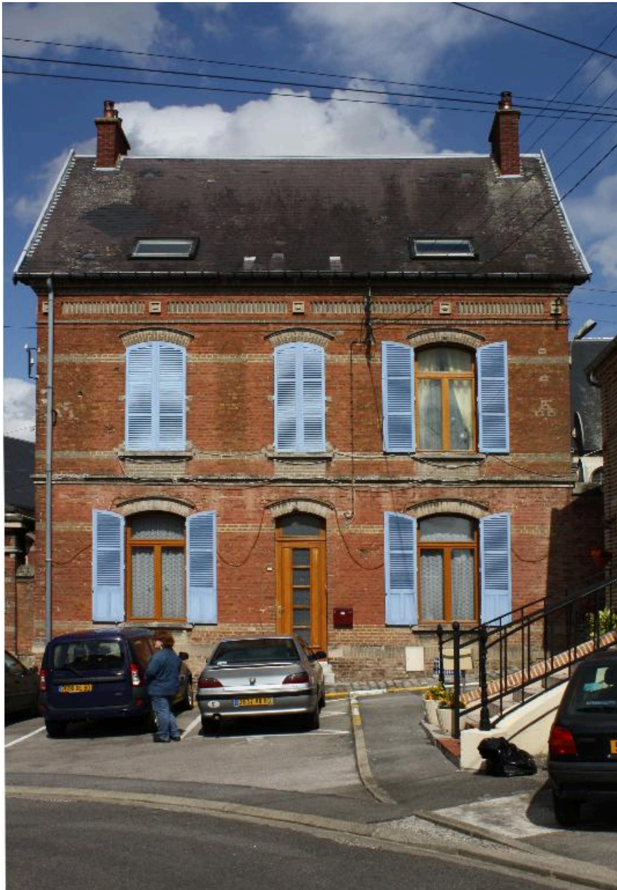
Façade sur rue du logement d'institutrice.
