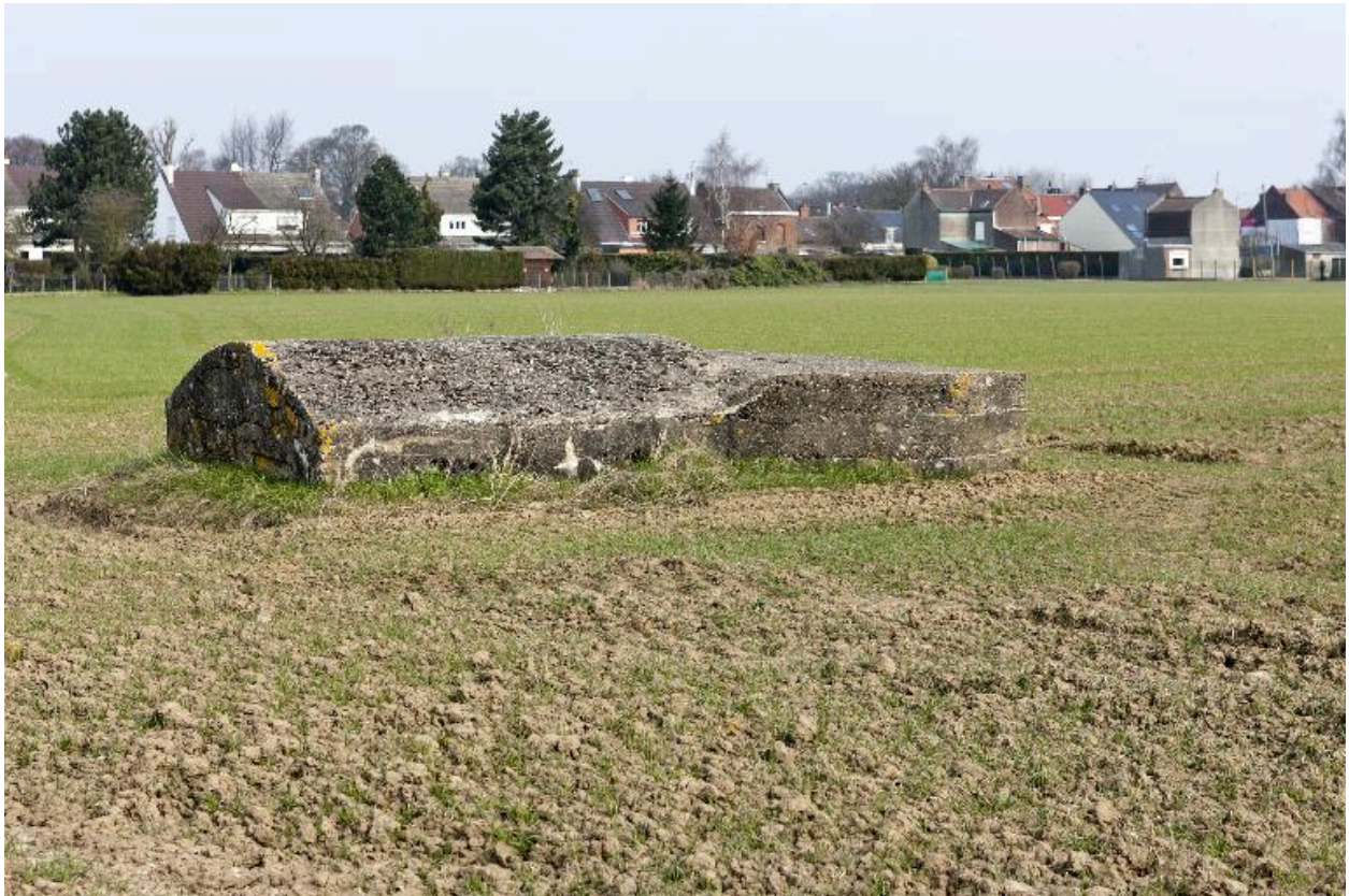
Vue vers le nord de la casemate a
