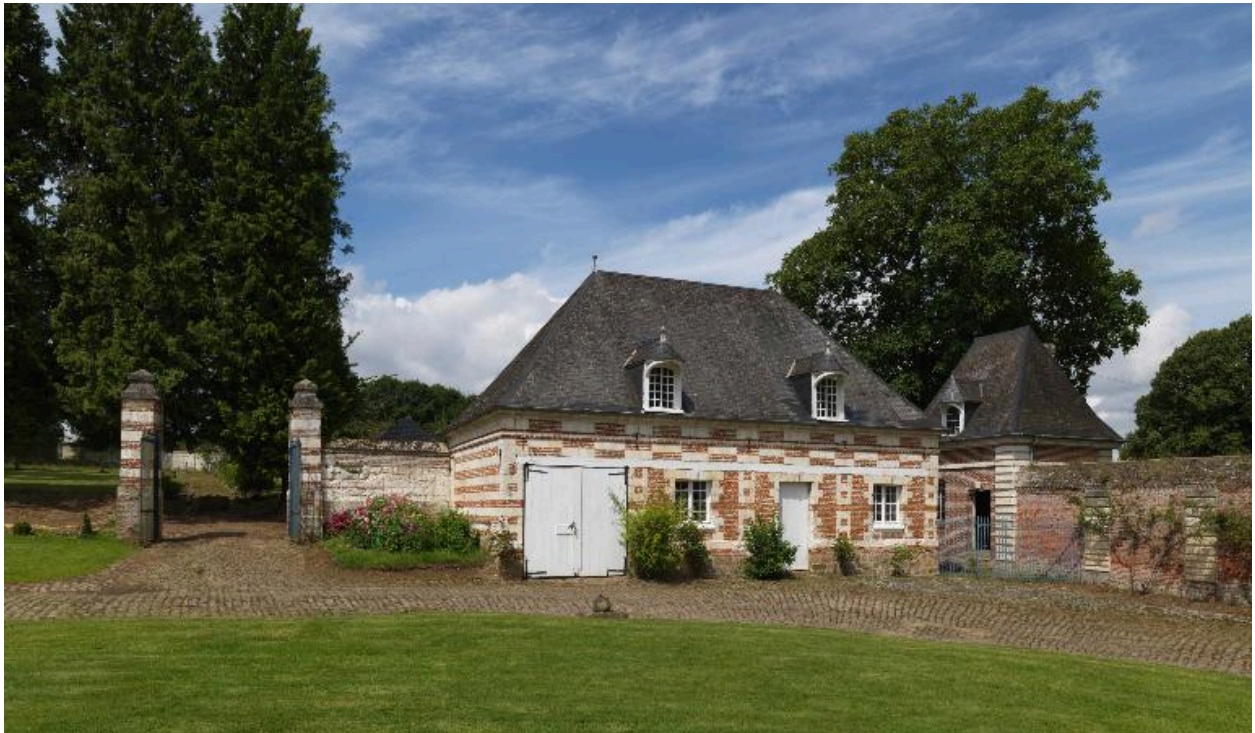
Porte du potager, logement et pavillon d'entrée.
