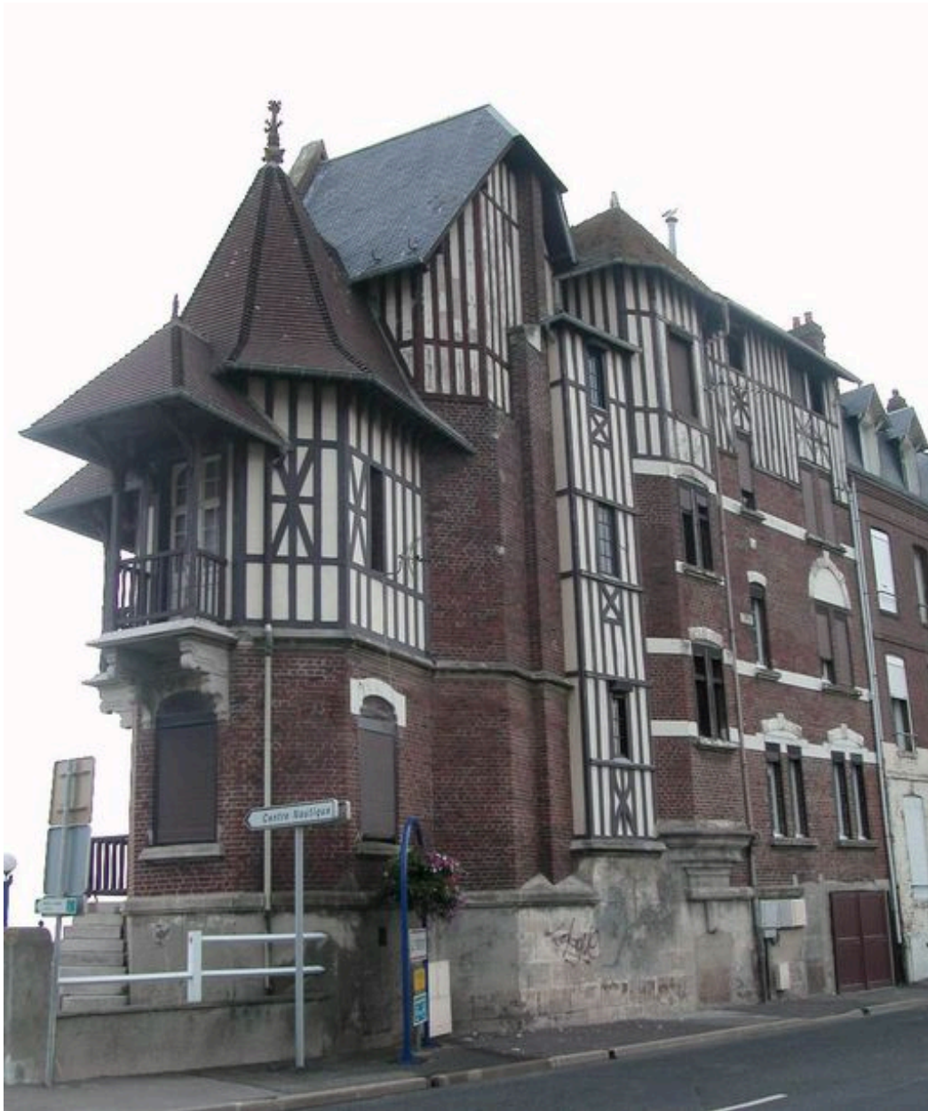
Vue de trois-quarts et élévation postérieure.
