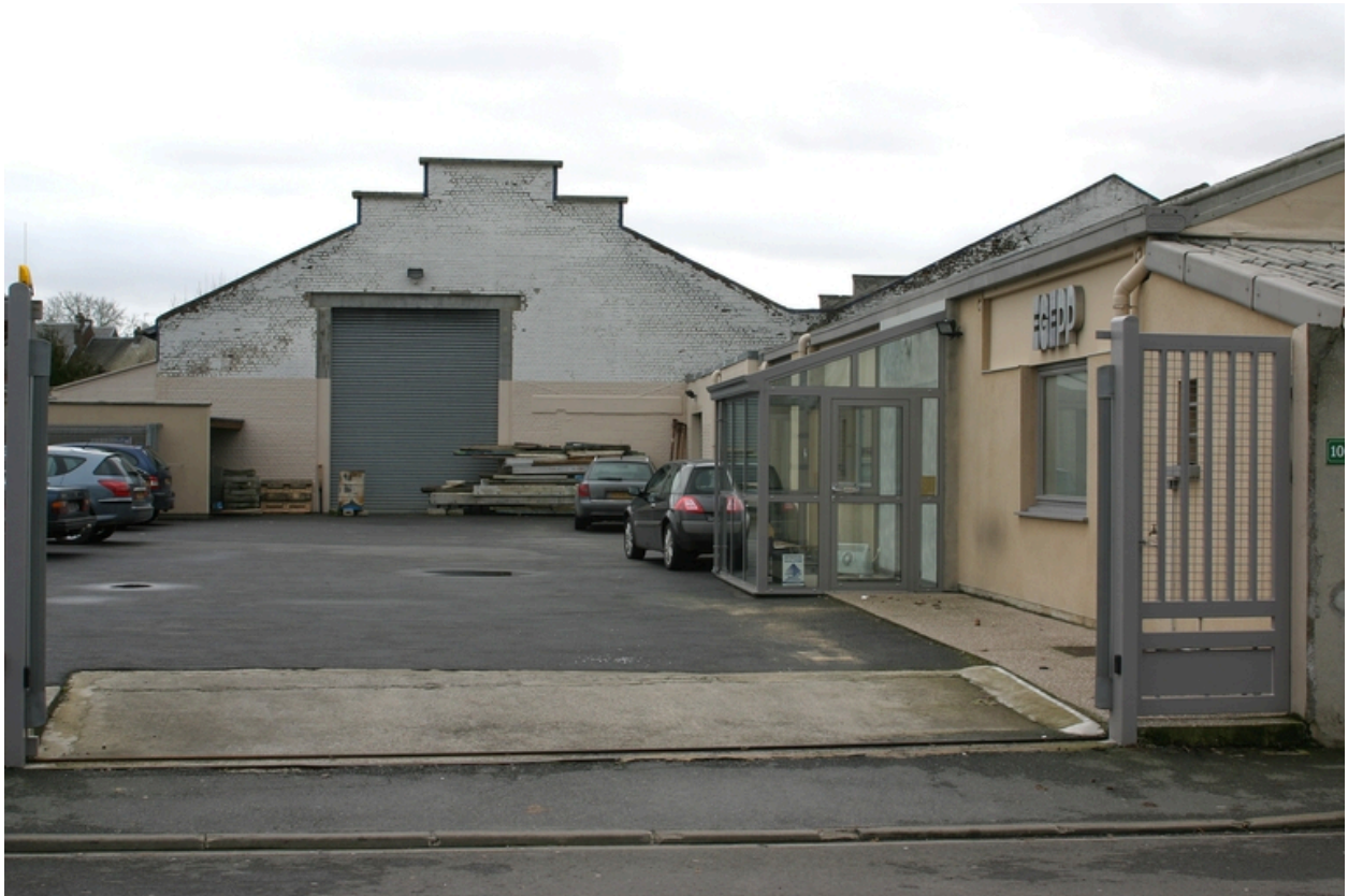
Pignon d'un atelier de 1947, vu depuis le chemin d'Harly.
