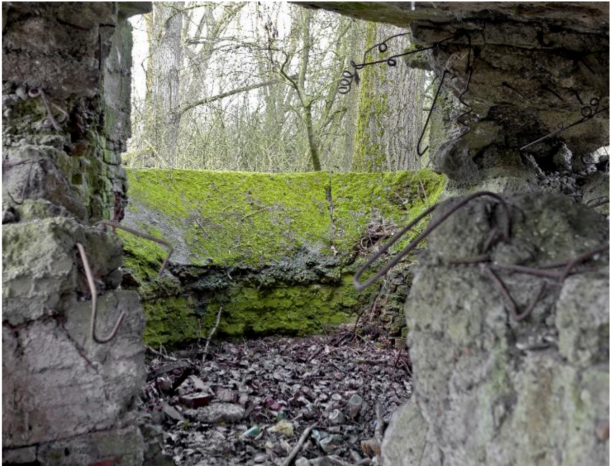
Vue intérieure, au fond, la cuve à canon
