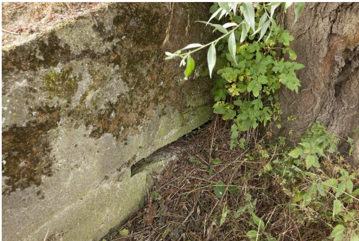
Casemate i. Embrasure dans le pignon
