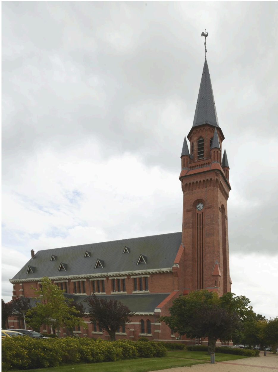
Vue générale, prise depuis le sud.
