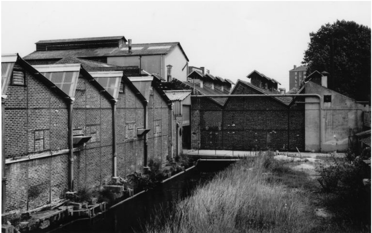
Les anciens ateliers de teinture et la passerelle d'accès à l'usine depuis le sud.
