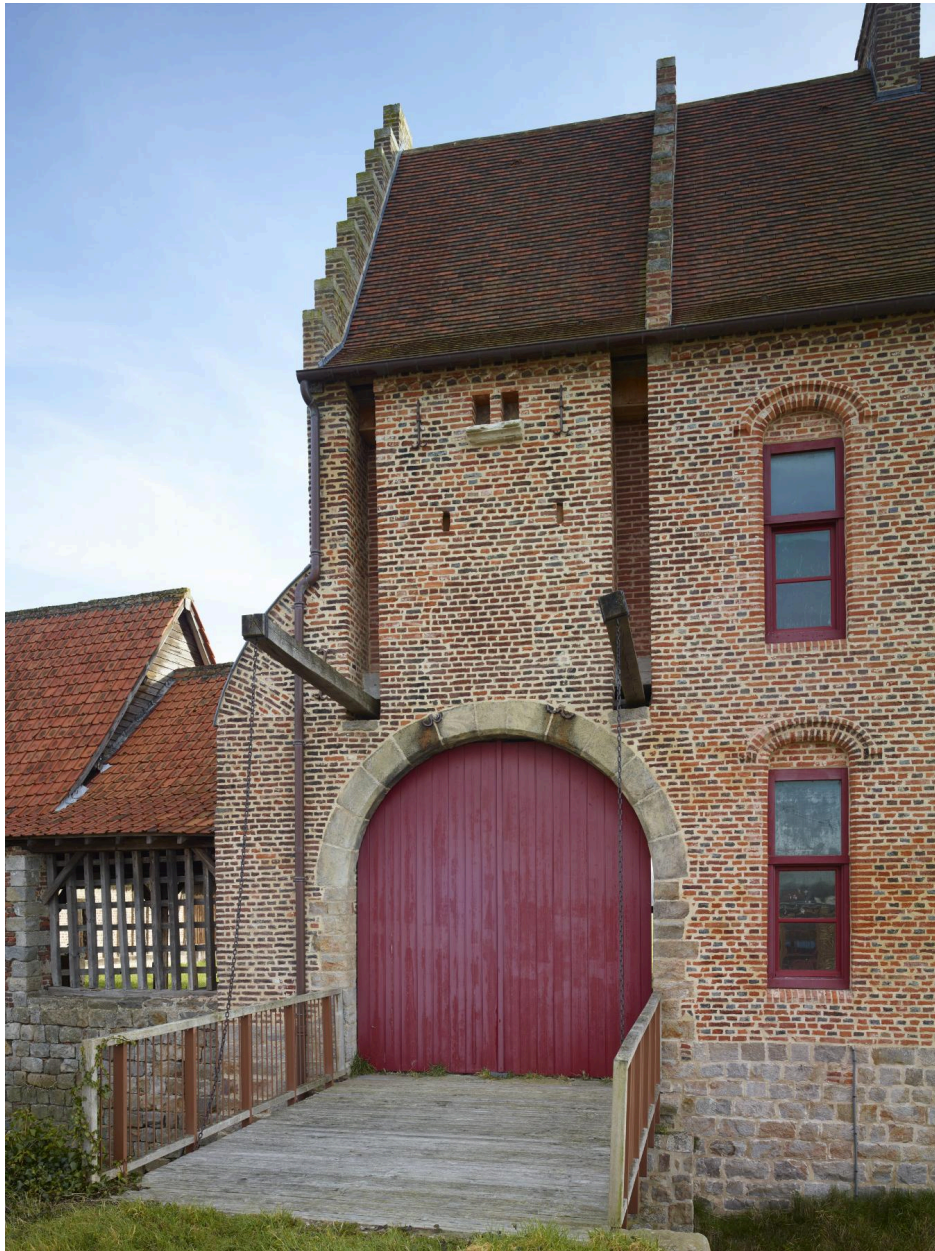
Tour-porche et porterie. Vue depuis la rue.
