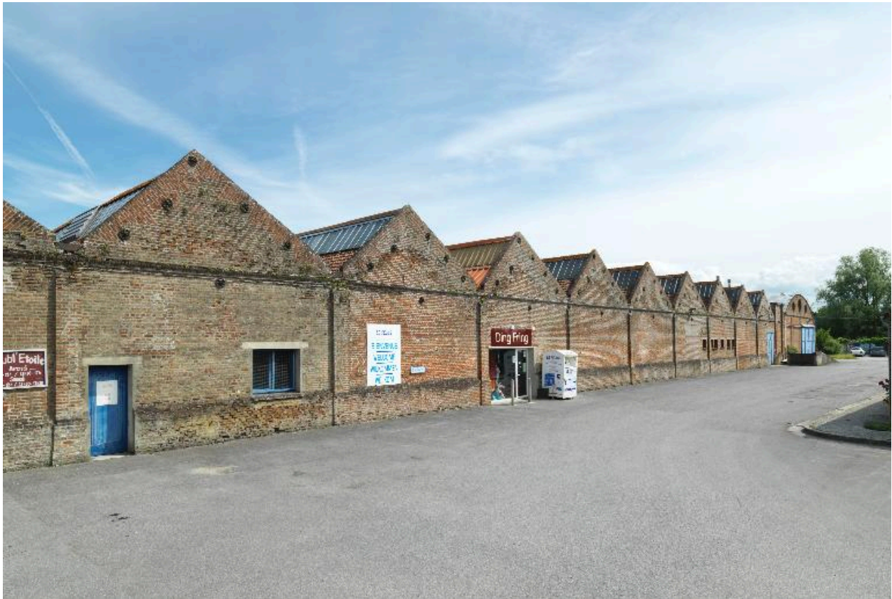
Vue d'ensemble nord-ouest de l'atelier de tissage.
