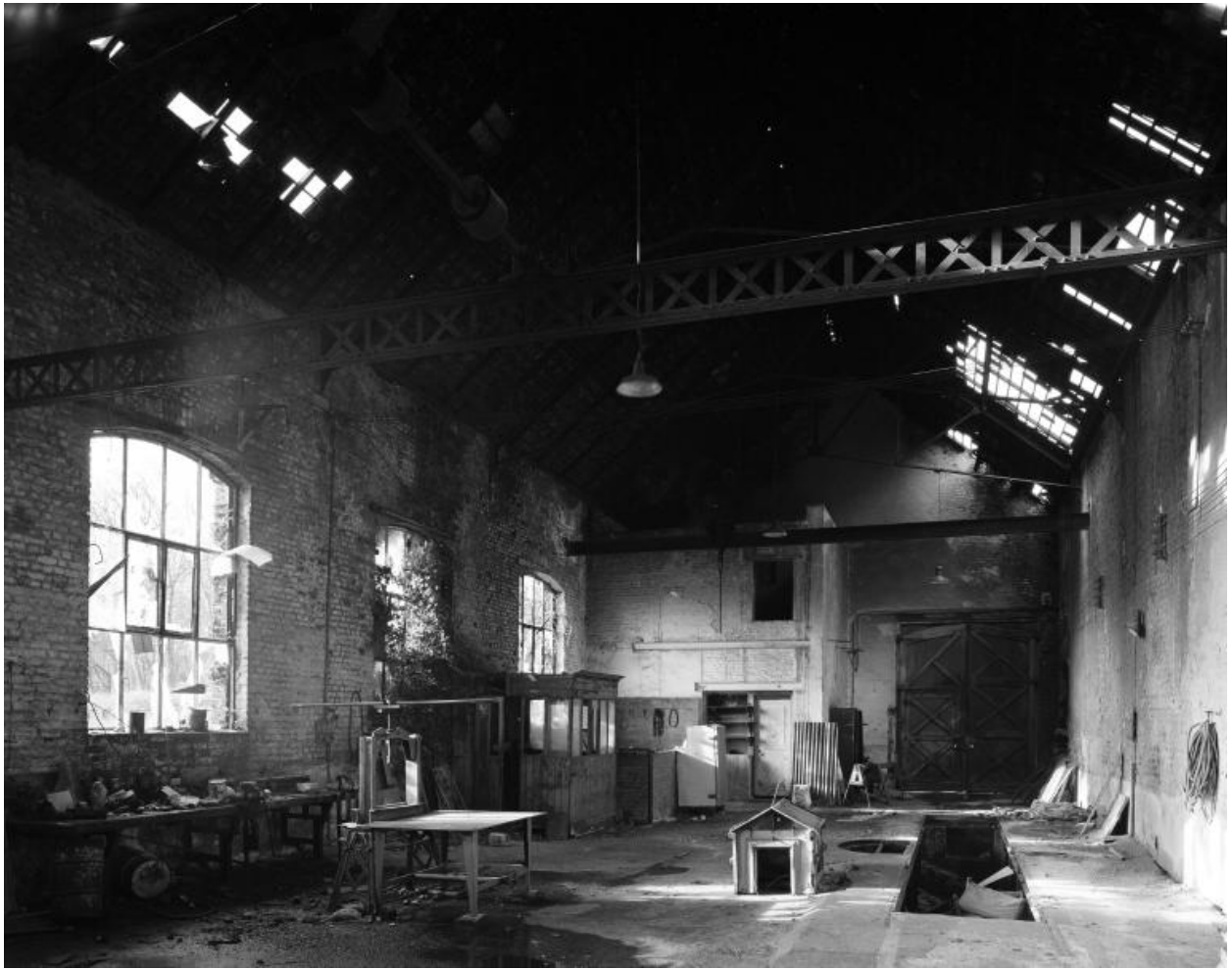
Atelier de réparation, vue intérieure.
