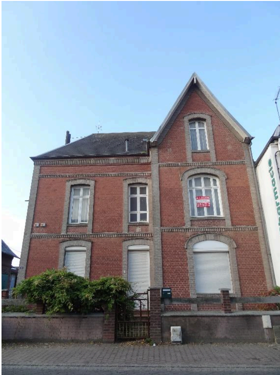
Vue générale du logement patronal.
