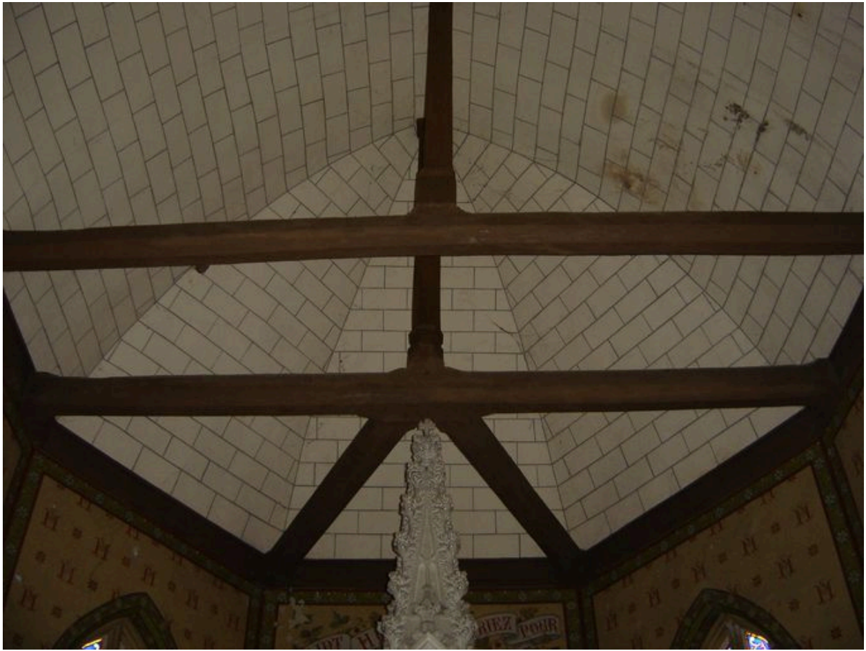
Détail de la charpente apparente dans le choeur.
