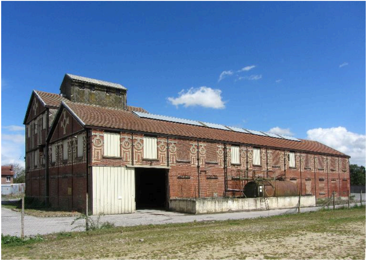
Vue d'ensemble sud-ouest de le l'atelier principal de la râperie.
