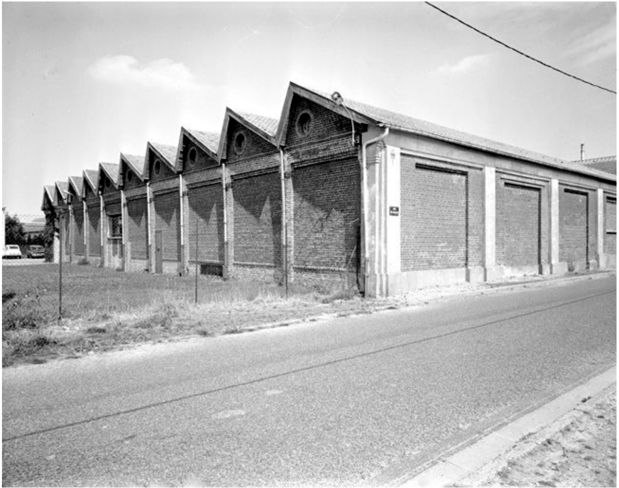
Corps du bâtiment C, flanc sud ouest.
