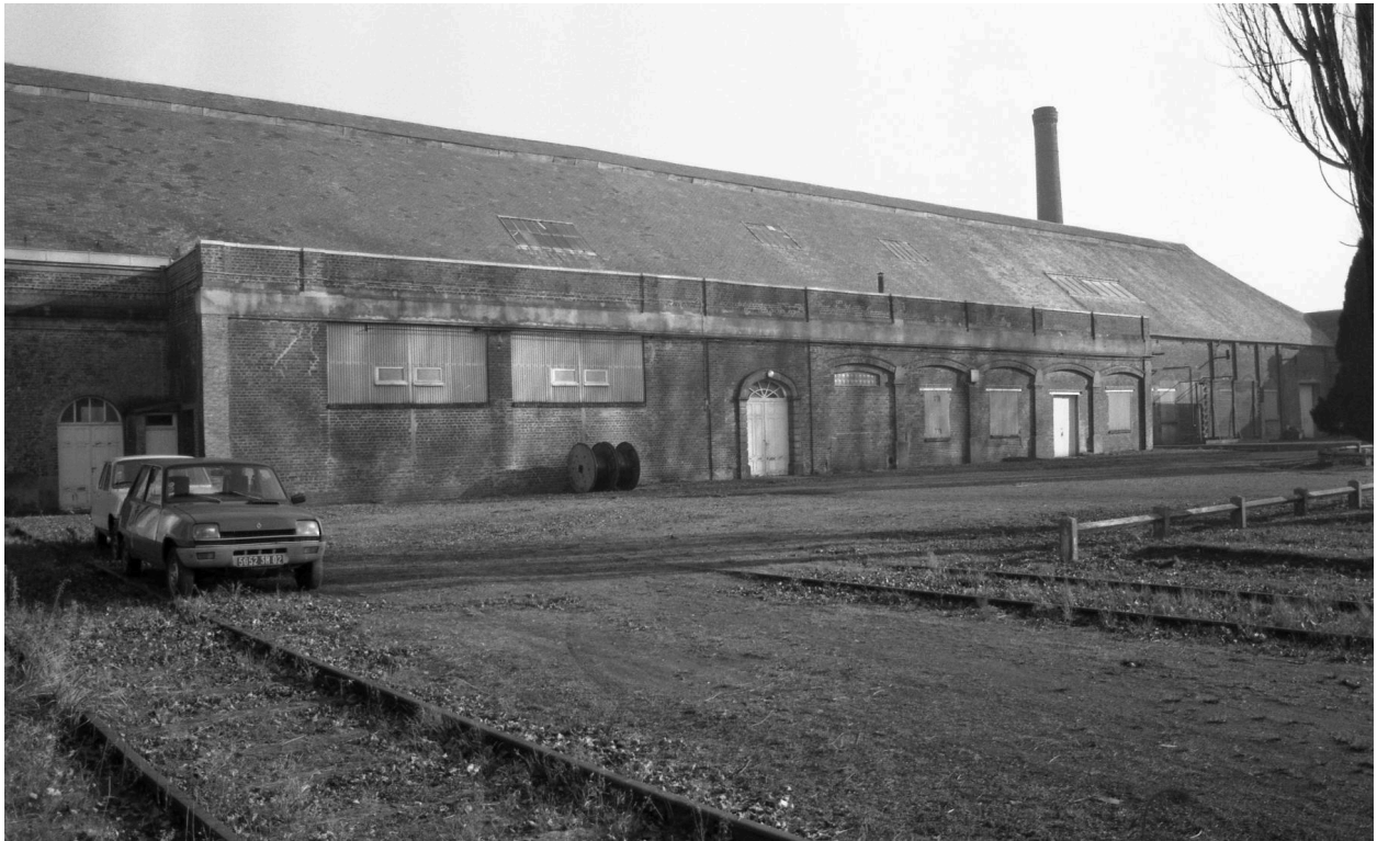
Façade sud de la grande halle des fours de cuisson en 1989.
