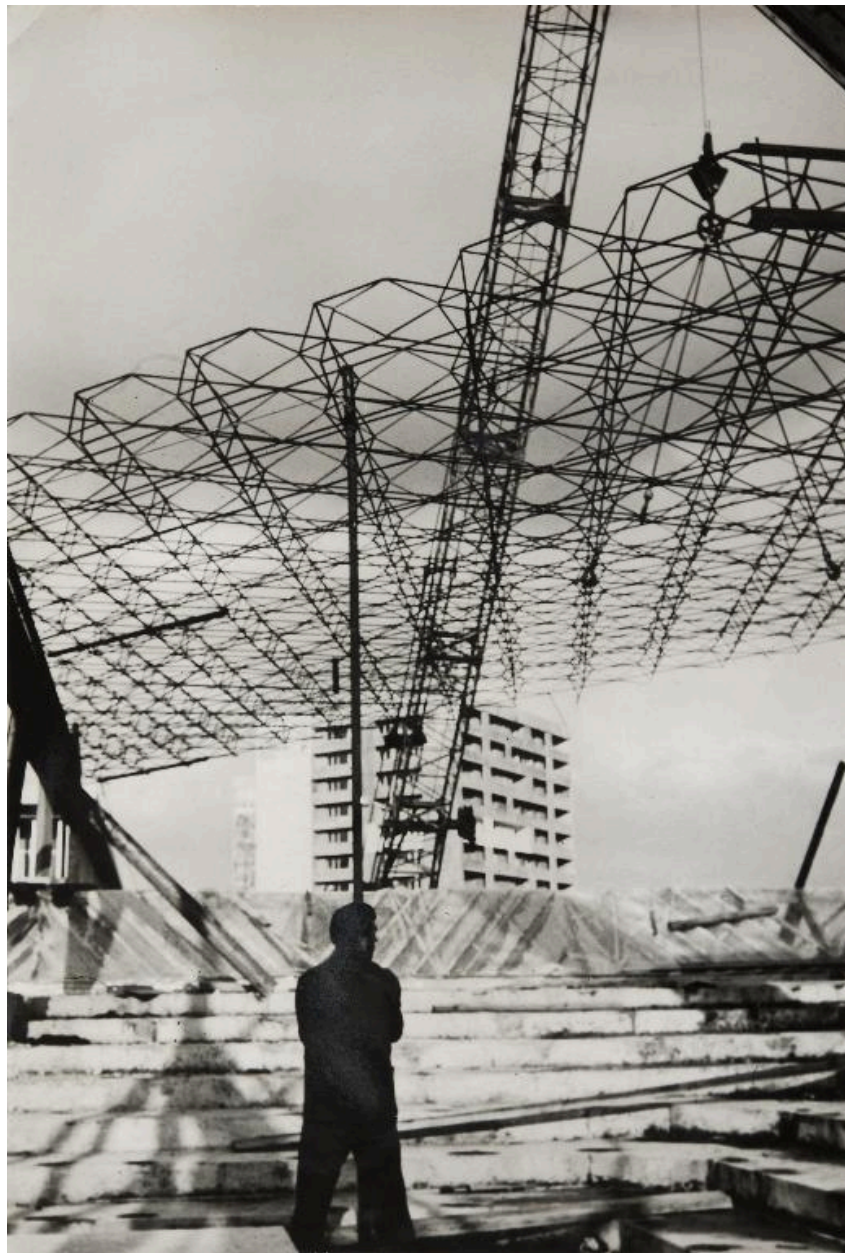
L'édifice en cours de construction. Pose de la résille en métal. Photographie, vers 1970. AP Jean XXIII, Saint-Quentin.
