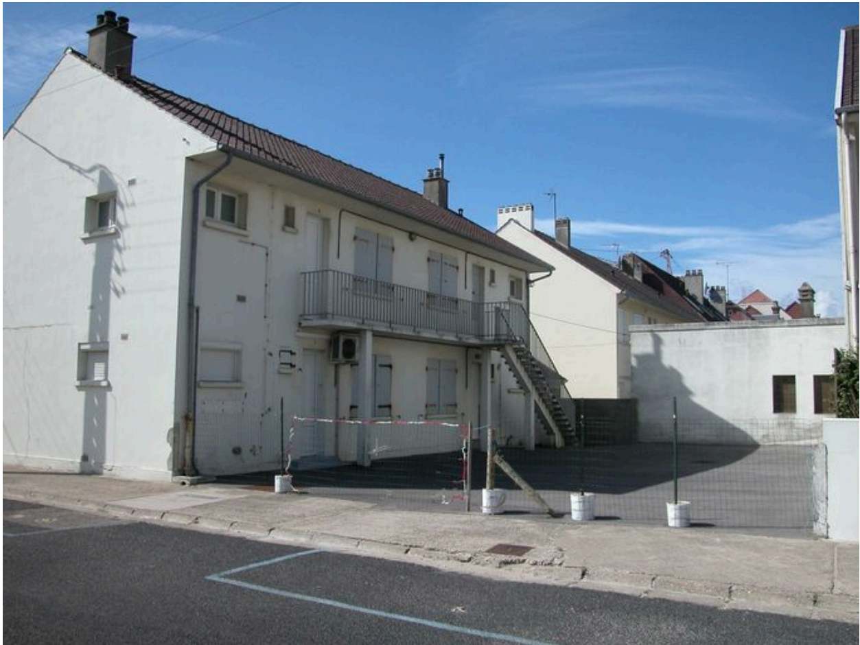
Façade postérieure d'une maison à plusieurs logements accolés et superposés (La Sablière, rue Balzac).
