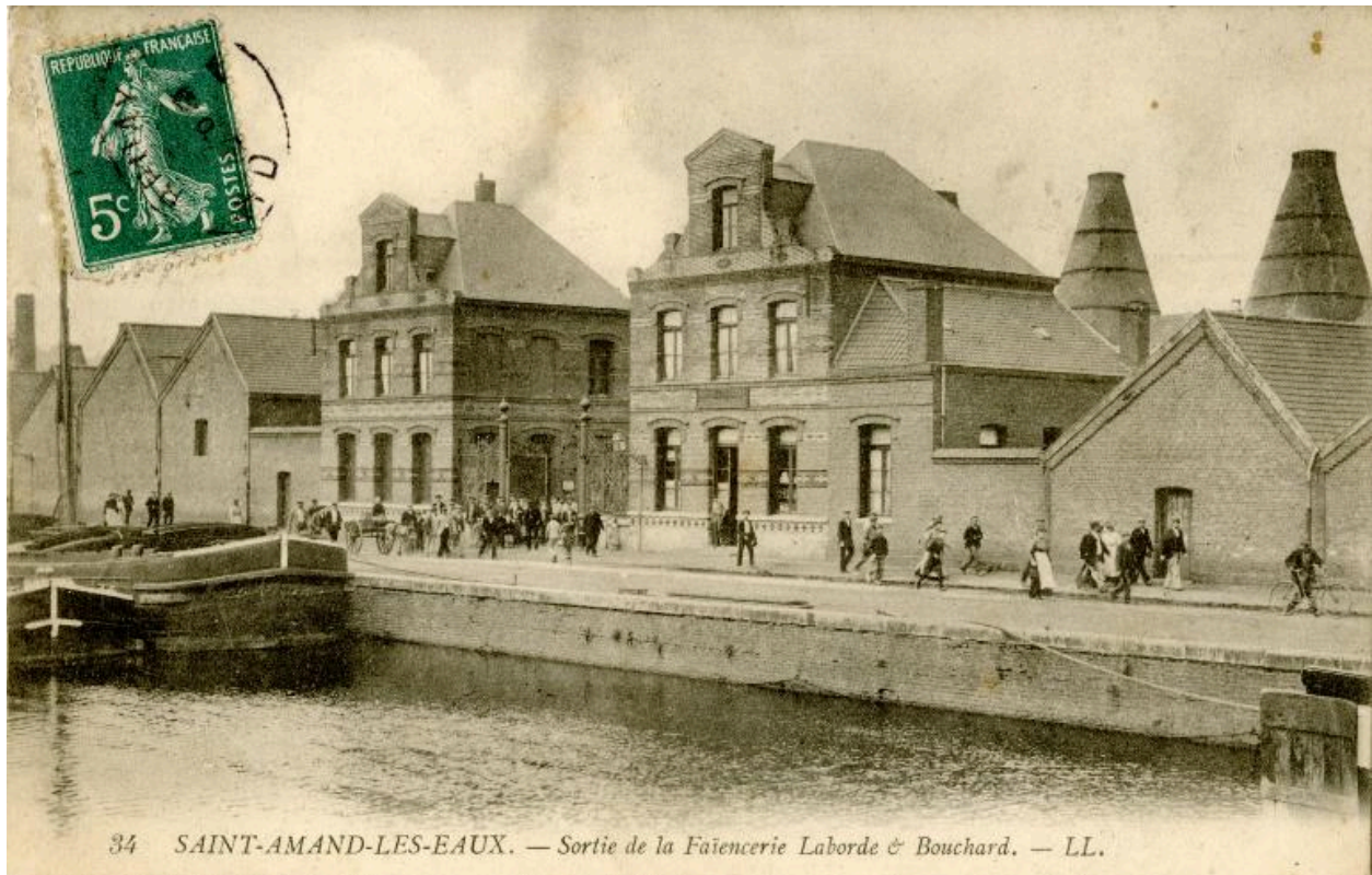
Pavillons d'entrée de la faïencerie Laborde et Bouchart (anciennement Lebacqz), vers 1910, carte postale (Médiathèque Saint-Amand-les-Eaux).
