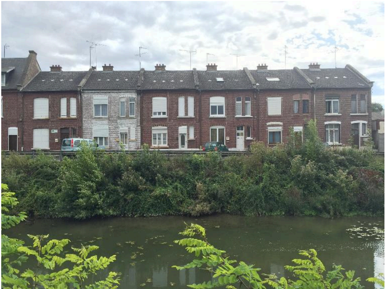
Les logements de la cité de la Clouterie, façade donnant sur le canal.
