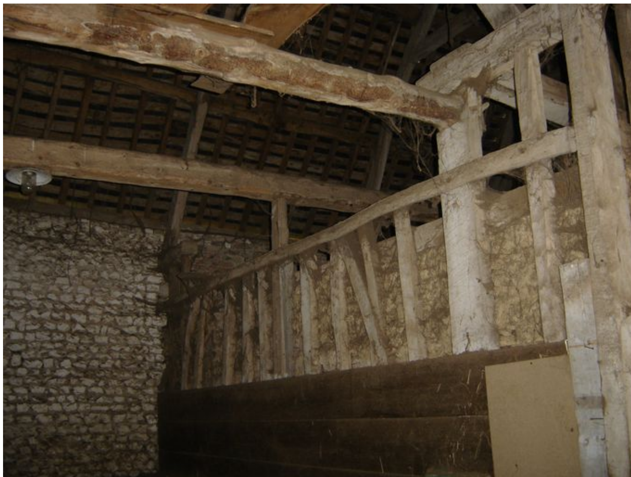
Vue intérieure de la grange.
