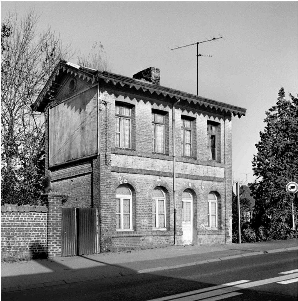
Vue du bureau d'octroi sis au n°645, rue des Docteurs-Devillers, construit sur un modèle identique à celui de la rue de Robbé.
