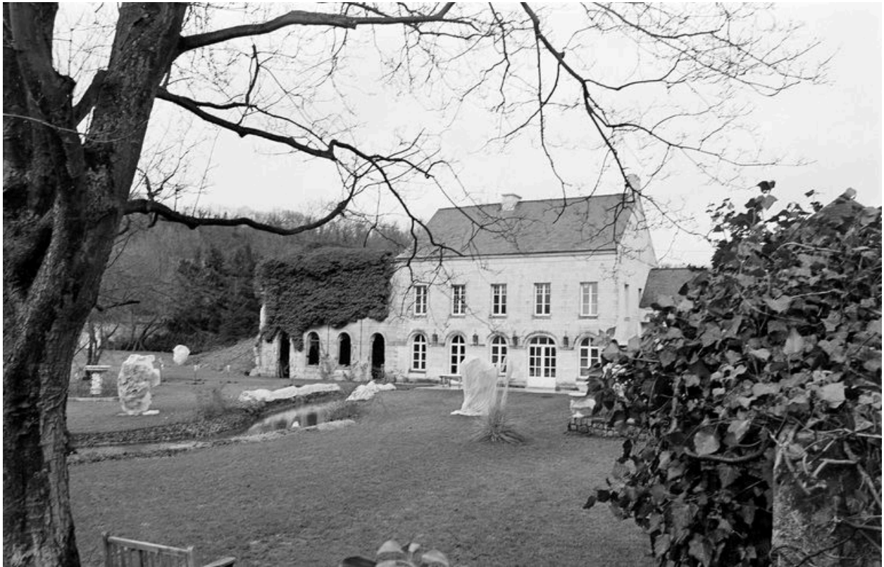
Atelier de fabrication, bâtiment d'eau et logement patronal, façade sud.
