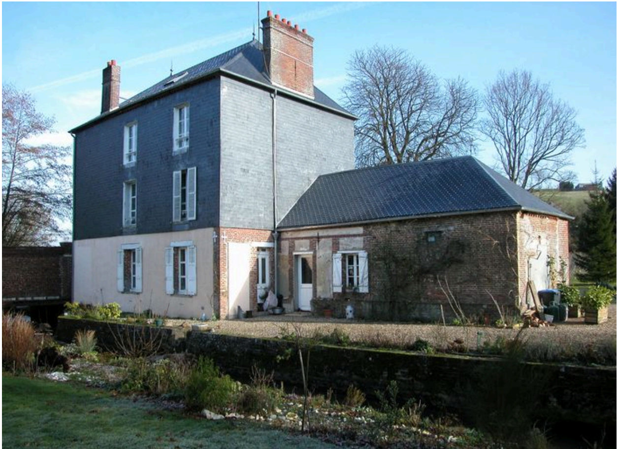
Vue d'ensemble postérieure.
