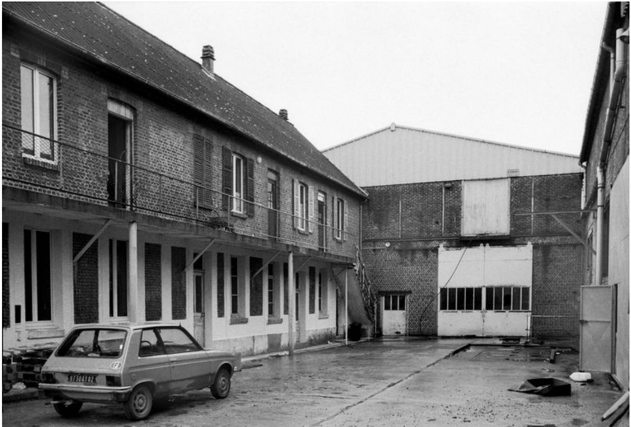
Cour intérieure, flanc ouest.
