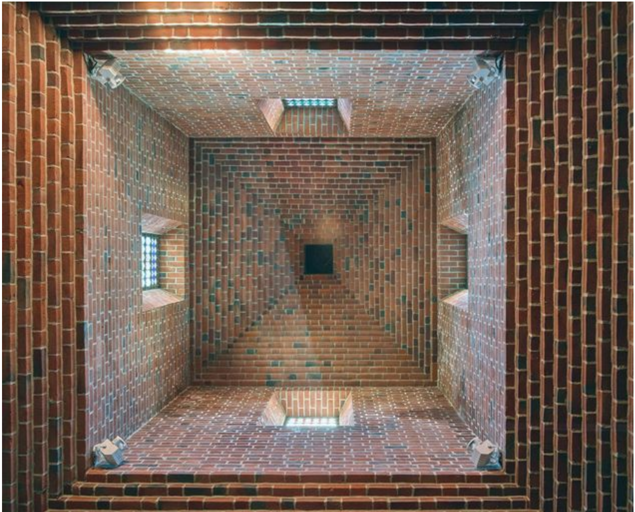
Vue en contre-plongée de l'intérieur du clocher.
