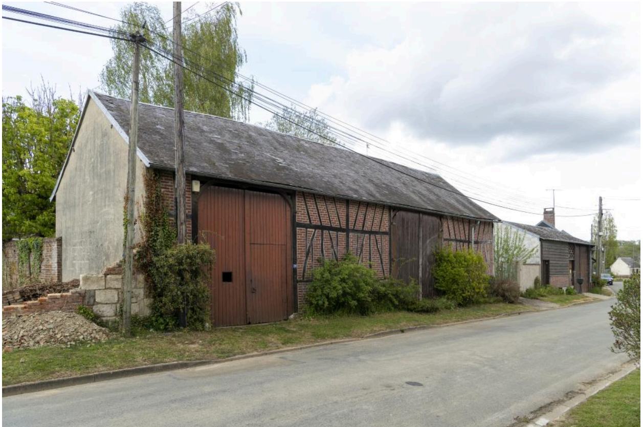
Grange et entrée charretière alignés sur la rue, n°29 Grande Rue, vue depuis le sud-ouest.
