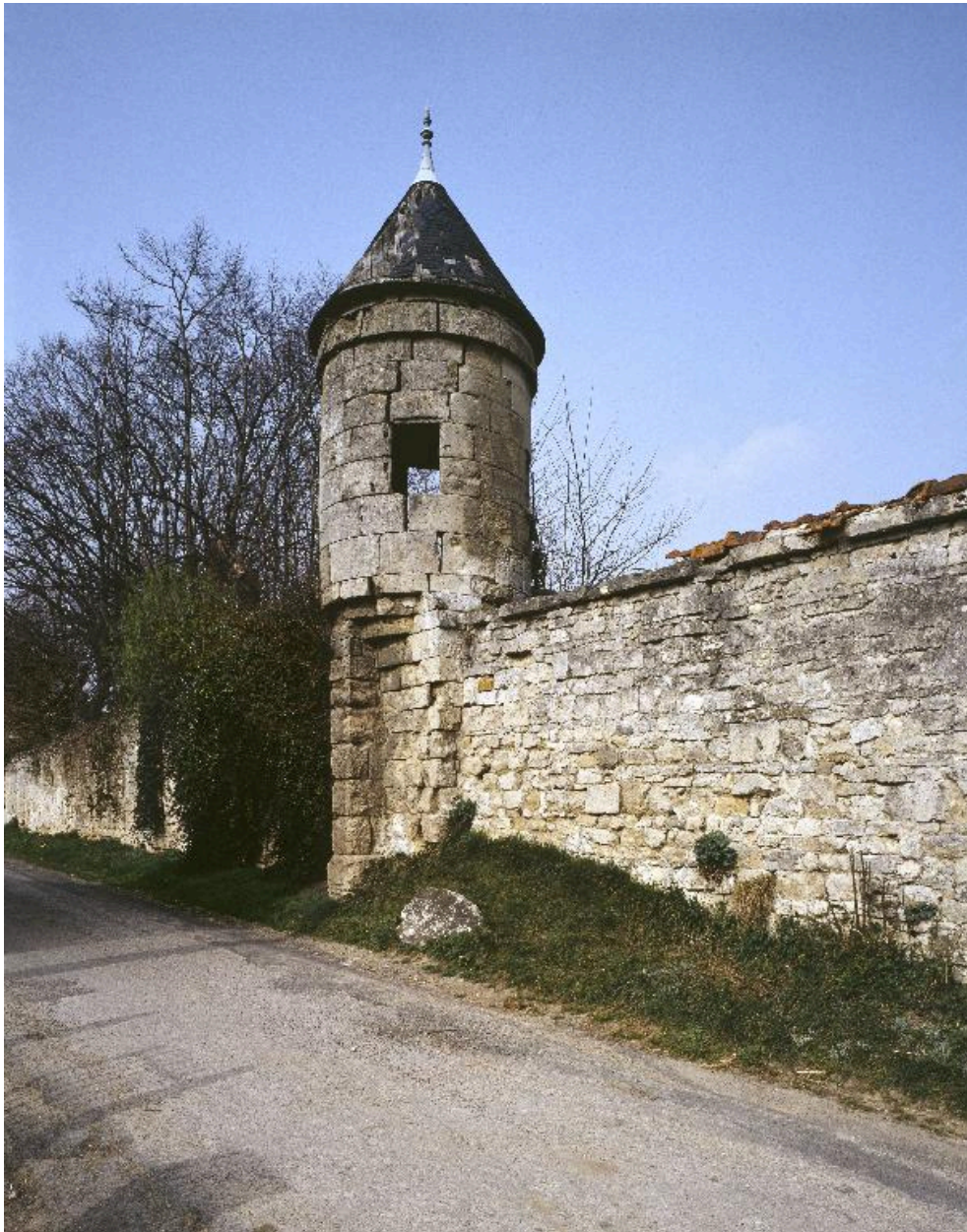
Vue de l'échauguette du mur d'enceinte, rue de Queue d'Ham.
