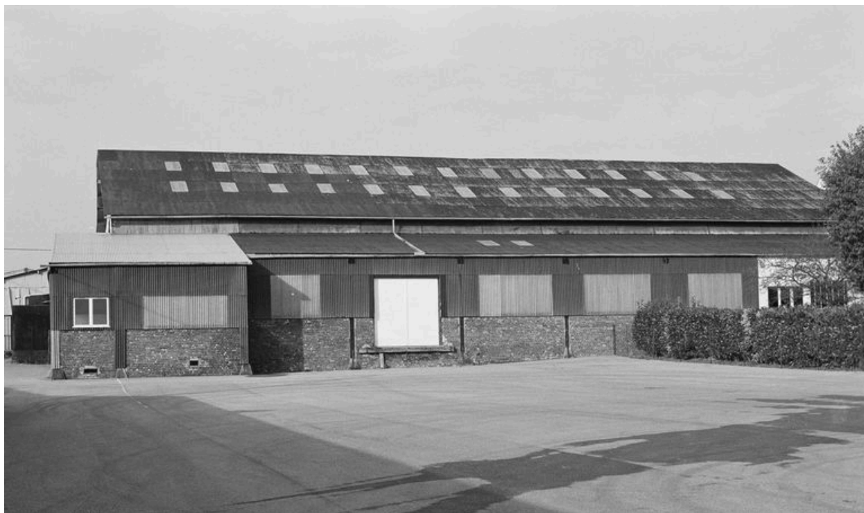
Atelier principal de sciage : façade longitudinale sud.
