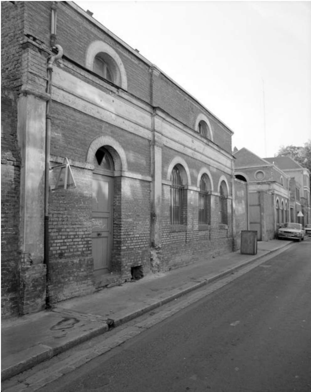
Vue générale de la rue Vivien prise depuis le nord-est.
