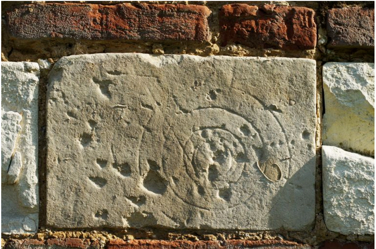
Graffiti sur l'élévation arrière du bâtiment du potager.
