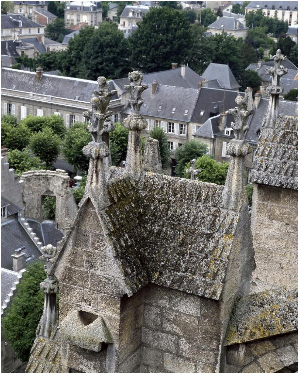
Partie supérieure de la culée d'un arc-boutant de la nef.
