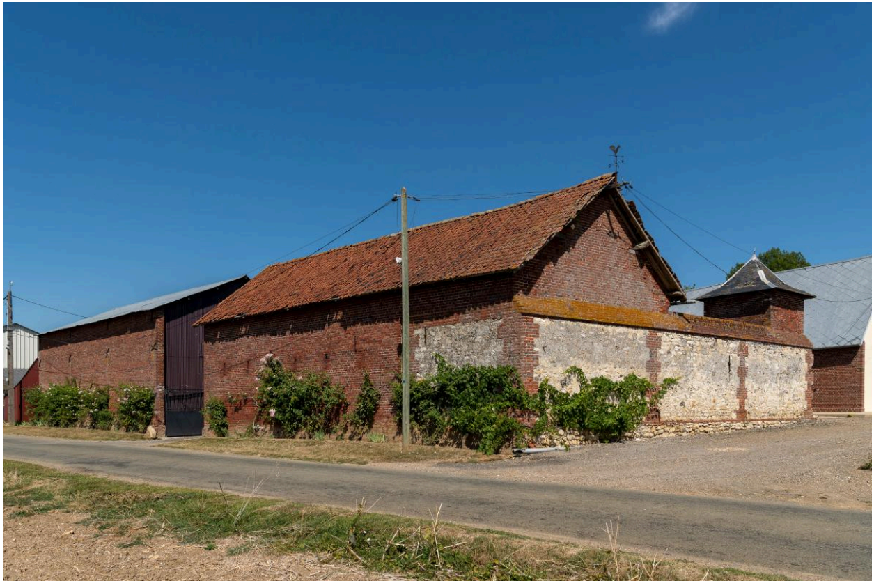
Ferme, n°1 rue du Plessier-sur-Bulles, vue depuis le sud.
