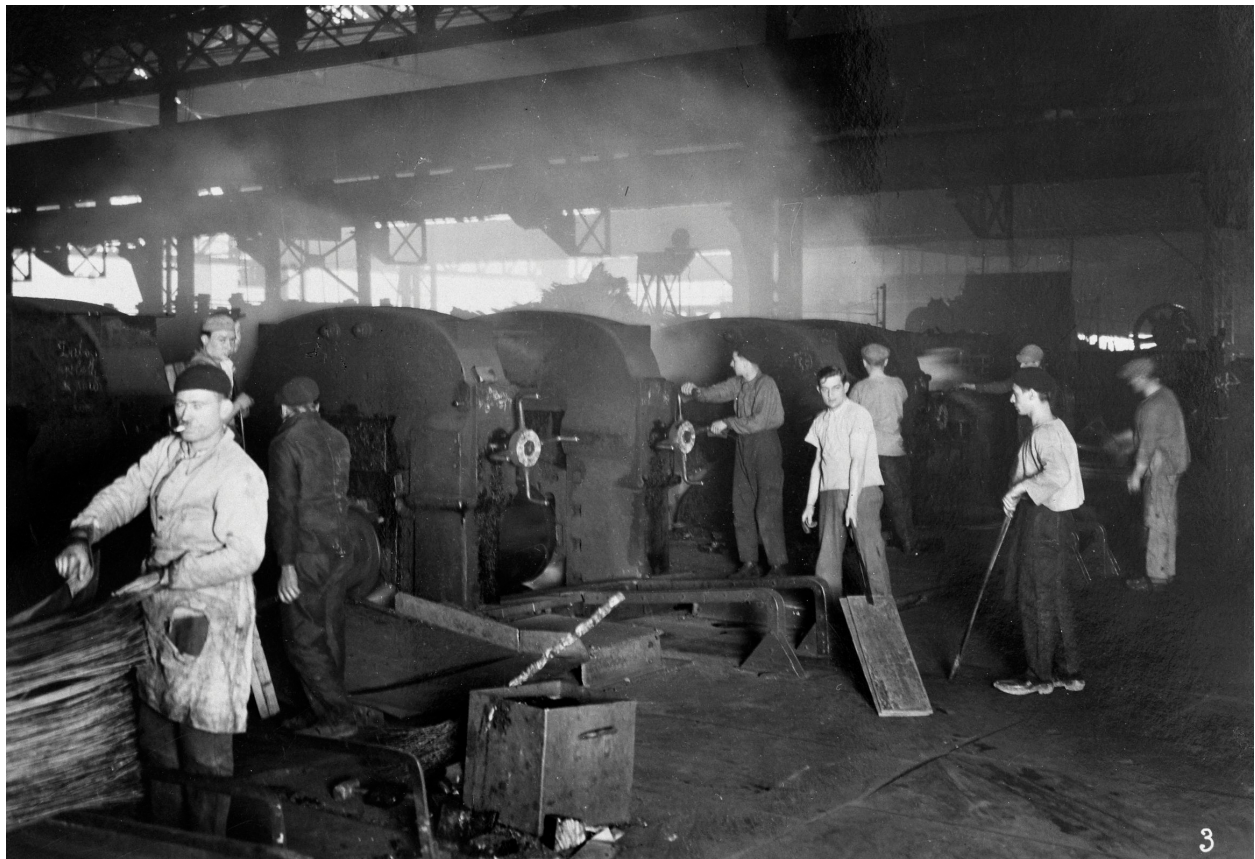
Train à chaud (four et laminoir à fines tôles). Photographie ancienne, auteur inconnu, sans date (coll. part.).
